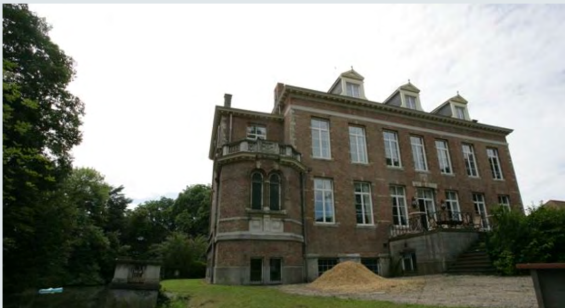
Foto achtergevel van kasteel Expoel met aan de linkse zijde de aangebouwde kapel
