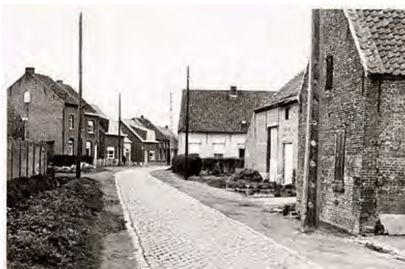
De plaats van het onheil, de Blaesveltstraat in Leest 9
