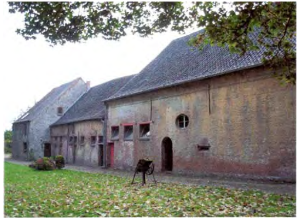
Na de storm wordt de schuur opnieuw opgebouwd. Ze staat er nu nog steeds
