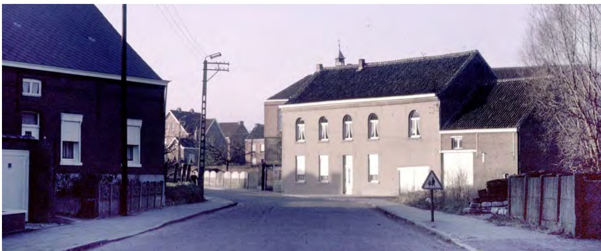
Het "Nieuw Huis" tot 1943 een bekende herberg met balzaal op de eerste verdieping, ouderhuis Lauwers - Philips
