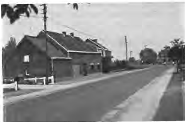
Foto genomen van de huizen die nu staan op de plaats waar eertijds "Het Haesken" gelegen was.
