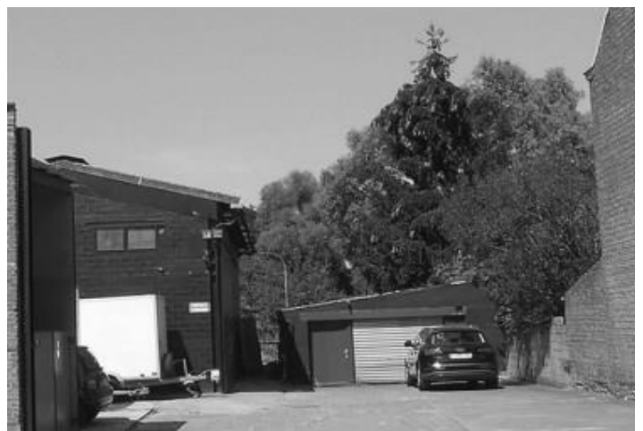
Links achter De Nieuwe Zaal (1908)
