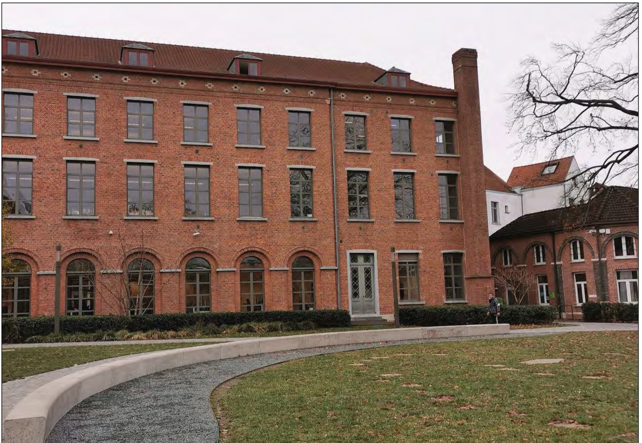
Kloostergebouwen gezien vanuit de kloostertuin richting Schipstraat Nu: OCMW-Sociaal Huis
